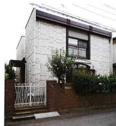
▲高橋さん宅から徒歩圏内。1983年に建てられた、大手住宅メーカーの鉄骨プレハブ住宅。軽量コンクリートの壁が耐火・断熱性にすぐれている。
