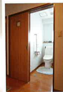
▲出入り口をドアから引き戸にし、廊下とフラットに。
