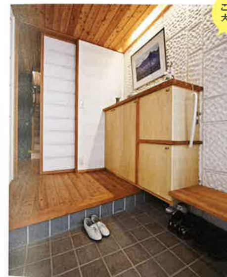
▲下駄箱は手すりとしても使えるよう、三和土と上がり框にまたがって設けた。LDKとの境は、ワーロンという障子紙に似た素材を太鼓張りにした引き戸に。開け閉めがラクにでき、断熱性もよい。
